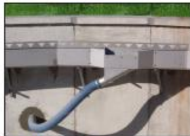
KD 16.08 Flydeslamsudtag, monteret direkte på KD 16.18 rustfri afløbsrende, hvor side mod centerdel virker som Flydeslamskant. Kan også monteres på KD 16.17 Flydeslamskant.
