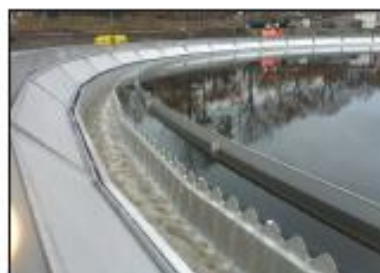
KD 16.18 rustfri afløbsrende med hakkant på begge sider, samt KD 16.17 Flydeslamskant.
